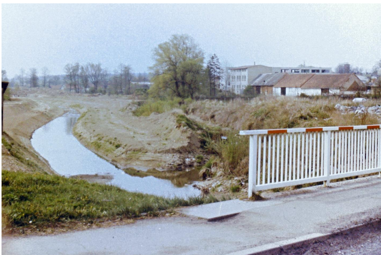
Budování nové regulace potoka Lysá v roce 1987
