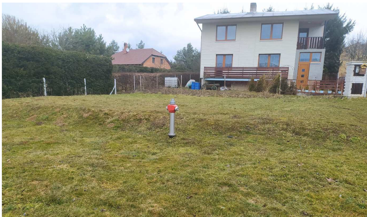
Obrázek 5: Umístění požárního hydrantu
