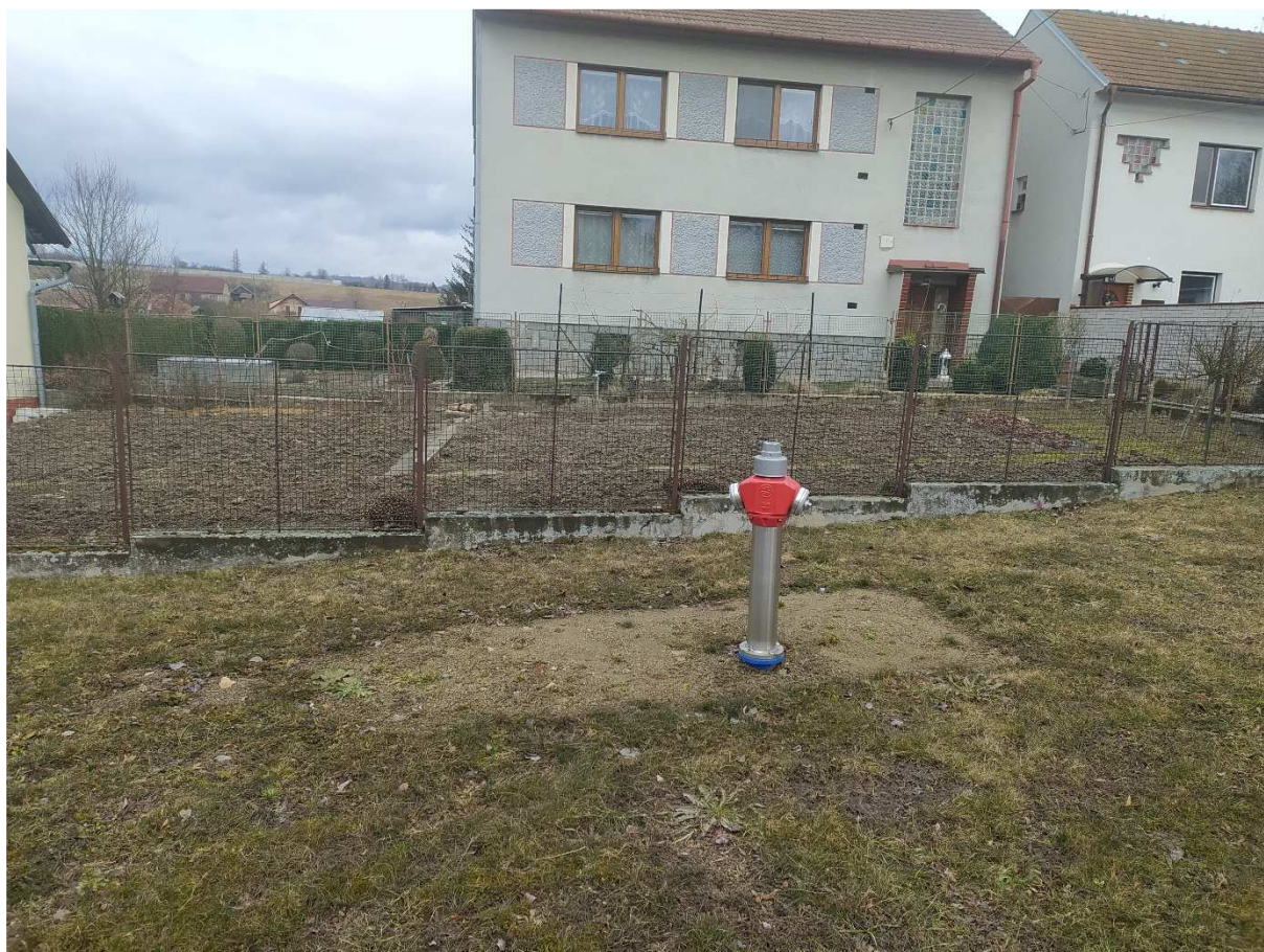
Obrázek 7: Návrh umístění nadzemního hydrantu v zeleném pásu.
