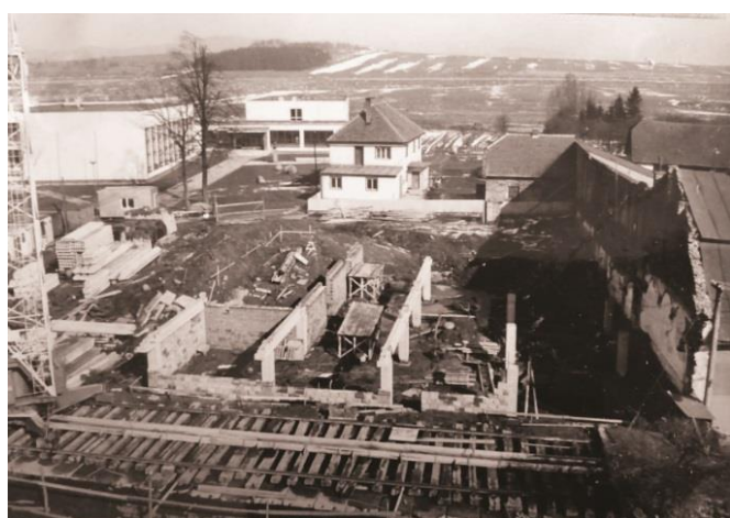
Hrubá stavba ukončena, rok 1975
